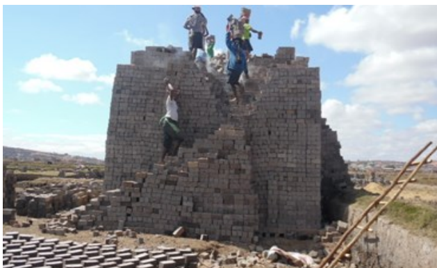
Cliché 2 : Four avec du mélange de balle de riz et fine de charbon comme combustible
