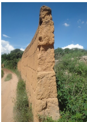
Figure 2 : Vue de profil d'un mur ancestral de Manandriana
