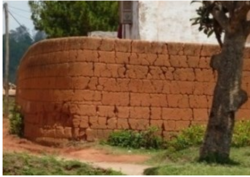
Figure 4 : Mur avec coin arrondi à Ambatofotsy Avaradrano
